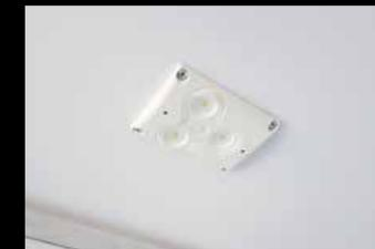
**Iluminación interior de LED:** panel de luces encastradas, sin interruptor con mando por sensor PIR con temporizador (10'). Solución de bajo consumo eléctrico y durabilidad extrema.
