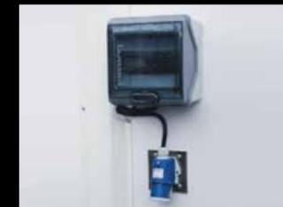
Mando del grupo y conexión a la red: El mando digital permite regular la temperatura de consigna y mostrar la temperatura real. Una toma externa, equipada de un alargador específico (de 8 m opcional), sirve para unir la función de red (opcional) a la red doméstica de 230 V (mín. 16 A).
