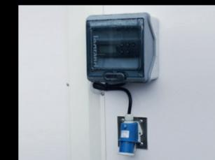
**Comando gruppo e raccordo corrente:** Il controllo digitale permette di regolare la temperatura impostata e di mostrare la temperatura reale. Una presa esterna, dotata di una prolunga specifica (da 8 m in optional), serve a collegare la funzione elettrica (optional) alla rete domestica 230V (min. 16 A).
