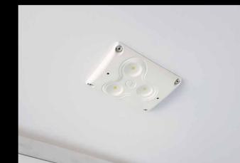
**Eclairage intérieur LED** : Plafonniers encastrés, sans interrupteur avec commande par capteur PIR temporisé (10'). Solution à faible consommation électrique et d'une longévité extrême.
